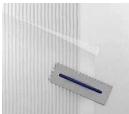
Überlappung des Armierungsgewebes mit ca. 10 cm
