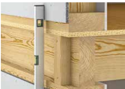
Ausrichten an der Wand
