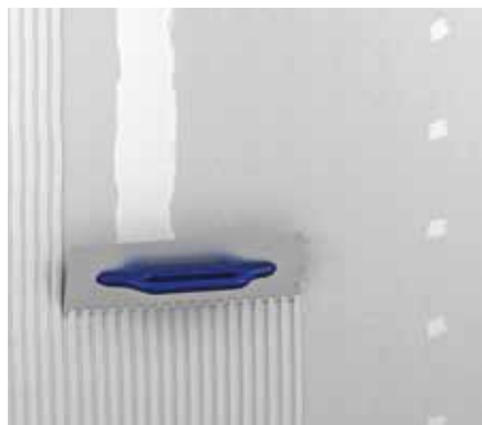
Aufbringen der Armierungsschicht
