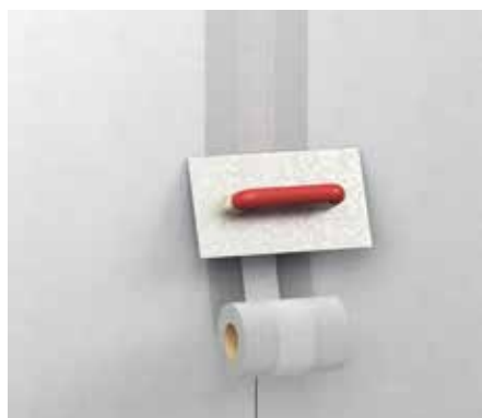
Aufbringen des fermacell Armierungsbandes HD
