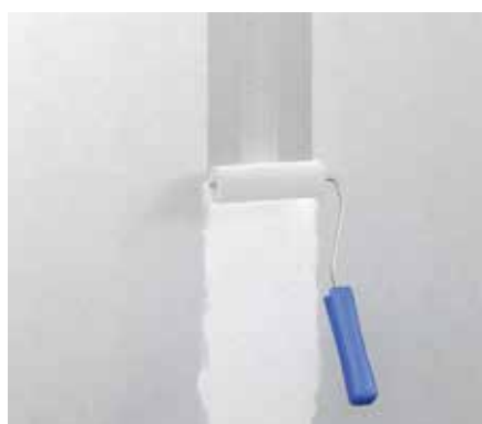
Aufrollen des fermacell Armierungsklebers HD
