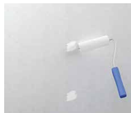
Deckendes Abtupfen der Verbindungsmittel in Plattenmitte
