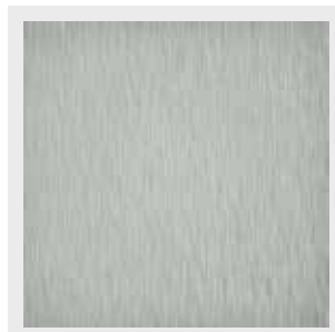
Matēta betona struktūra
